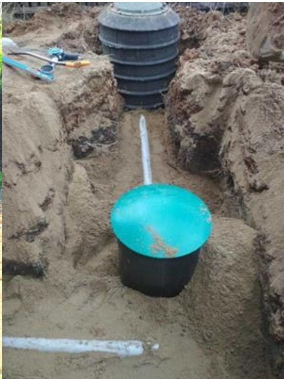
5. После засыпки септика песком (до уровня входа в септик) и заполнения его водой можно производить подключение труб канализации (вход и выход), силового кабеля(при подкл. дренажного насоса). Вход в септик при стандартной комплектации предусмотрен на уровне 600мм. Если отводящая труба уже проложена ниже уровня, необходимо нарастить горловину добором (не более 1000мм). Затем, осуществляется полная засыпка песком. Крышка горловины септика должна выставляться над поверхностью земли на 50-100м.
